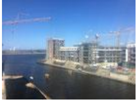
Neubau Wohn- und Geschäftshäuser Holzhalbinsel, Rostock
