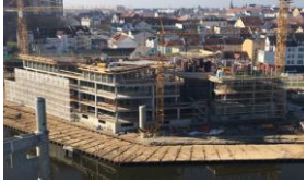
Neubau Büro- und Diagnostikzentrum CentoNew, Rostock
