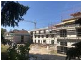
Pflegezentrum mit Hospitz in Waren
